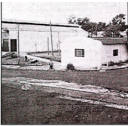
Vista da Capela São Pedro velha e a nova em construção
